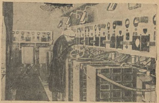
Рис. 16. Никелировочное отделение. в — электролитические ванны; н — никелированная матрица
