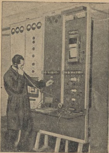
Рис. 6. Контрольно-измерительные стойки центральной аппаратной
